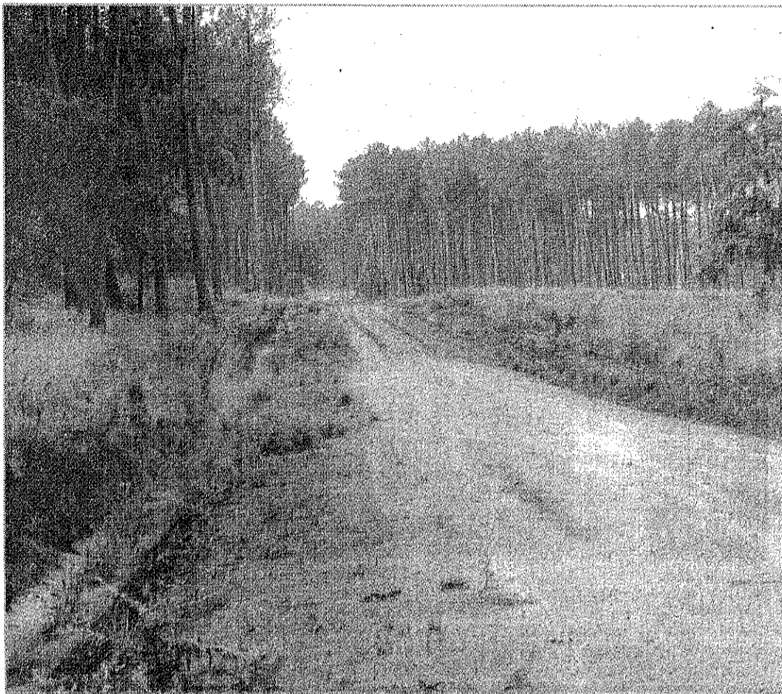
« Ce que tu feras pour la forêt, la forêt te le rendra »: la nouvelle piste de Pouysarraute destinée à l'accès des pompiers donne une plus-value à la forêt qui est ainsi plus facilement exploitable.
